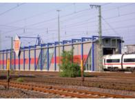
Das Herzstück der im Jahr 2000 errichteten Waschanlage ist die „Außenreinigungsanlage“, bestehend aus einer 8 m breiten und 125 m langen Industriehalle, eine Stahlkonstruktion im ICE-Design. Sie ist als weitgehend automatisierte Durchfahr-anlage konzipiert, durch die die Züge mittels zweier Radstrazwagen per Seilzugangertechnik gezogen werden. Je nach Betriebsprogramm werden täglich 7 bis 14 Züge unterschiedlicher Bauart gewaschen.
