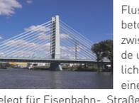
Eine 1970-1972 über den Fluss geschlagene Spann-beton-Schrägseil-Brücke zwischen dem Werksgelände und Sindlingen. Mit einer lichten Weite von 148 m bei einer Breite von 31 m ist sie ausgelegt für Eisenbahn-, Straßen- und Fußgänger-verkehr sowie als Rohrtrasse. Geplant von Karl Kreher, dem Leiter der Bauabteilung der Farbwerke Höchst, übernahm Dycykerhoff & Widmann die Ausführung dieser ersten Schrägseilbrücke der Welt in Spannbetonbauweise sowie der ersten Schrägseilbrücke für Eisenbahnverkehr.
