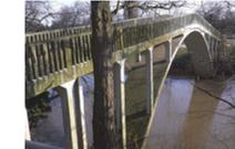
Dynamisch spannt sich als letzte der Niddabrücken der im Volksmund „Seufzbrücke“ genannte Fußgängersteg. Die Firma Buchheim & Meister betonierte 1913 die 42 m lange Eisenbetonkonstruktion als Bogenbrücke (23 m Stützweite) mit aufgeständerter Fußwegplatte und vertikal gegliedertem Betongeländer.
