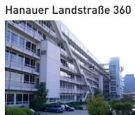
Ein sechsgeschossiges „Industriegebäude“ des Versandhandels von 1960 für 3.000 Arbeitsplätze, in gewaltigen Ausmaßen von 65 mal 257 Metern. Die von Egon Eiermann entworfene, neuzeitliche Architektur zeichnet sich durch die horizontalen Fluchtbalkone mit den schräg davor liegenden Treppentritten aus. Das Ensemble, einschließlich des Kraftwerks in konstruktivistischer Formgebung, steht seit Längerem für eine Umnutzung zur Verfügung.
