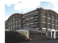
Das Lager- und Mühlengebäude verkörpert beispielhaft die in den Jahrzehnten um 1900 gültige Auffassung von Fabrikgestaltung. Die Fassaden trennen deutlich zwischen tragenden und nicht tragenden Teilen der Wand: Pilaster wandeln sich als Abbild des tragenden eisernen Skeletts im Inneren zu Mauerwerkspfeilern, zwischen denen sich die Wand in Glasflächen auflöst.
