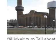
Die von der Grundkonzeption her symmetrische Anlage von 1923/24 addiert sich aus einem fast quadratischen Kesselhaus, beidseitig flankiert von Schornsteinen (der westliche 1984 wegen Bau-fälligkeit zum Teil abgetragen) auf übermächtig dimensionierten, polygonalen Basen. Im Auftrag der für die architektonische und technische Planung zuständigen AEG entwarf das Architektenteam Dr. Werner Klingenberg & Werner Issel ein formal in die Zukunft weisendes Kraftwerk.
