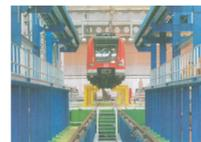
Das 220 mal 96 Meter große Gebäude wurde ursprünglich als zentraler Postbahnhof errichtet. Die 10 Gleise werden von einem trapezförmigen Raumfachwerk überspannt. Seit 2006 werden hier die S-Bahnzüge des Rhein-Main-Verkehrsverbundes RMV gewartet. Foto: Deutsche Bahn AG
