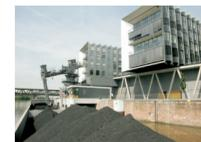
Die für das Heizkraftwerk notwendige fein gemahlene Kohle wird mittels eines neuartigen Krans aus den Kohlenschiffen befördert: in seinem „Rüssel“ dreht sich eine Archimedische Schraube, über die die Kohle auf ein Förderband gelangt, das durch die beachtenswerte Bürobebauung (2002, Architekten Schneider+Schumacher) in das Heizkraftwerk führt.
