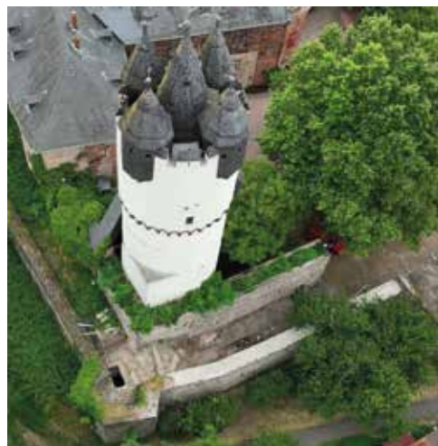
2/ Blick auf den Polygonalen Turm und Gewölbe.
