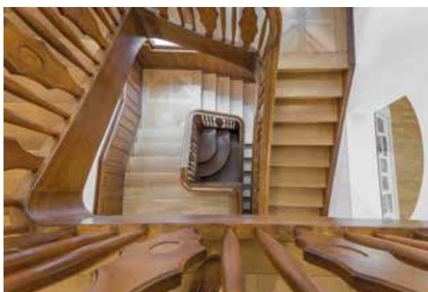
3/ Blick ins Treppenhaus im MGGU
