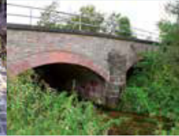
25 / Rodgau/Weiskirchen: Napoleon-Brücke aus dem Jahr 1810, in unmittelbarer Nähe findet 1799 die Schlacht an der Tannenmühle statt.
