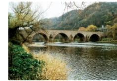
Siebenbogige Brückenkonstruktion mit markanten Eisbrechern an den Pfeilern und einer im ersten östlichen Brückenpfeiler integrierten frühromanischen Kapelle. Das unter dem Mainzer
