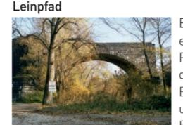
Bauliche Reste der 1913-15 erbauten, 1945 von deutschen Pionieren gesprengten Hindenburgbrücke inklusive Brückentürmen, Vorflutbögen und Sprengungstrümmern. Betonkonstruktion mit mächtigen dunklen Rustika-Quadern verkleidet. In der Flussaue zwei Bögen und der festungsartige Brückenkopf mit Schießscharten und Wappen des Großherzogtums Hessen nahezu unbeschadet erhalten. Neben der Bahnlinie Bingen-Mainz runde „Bastion“ in hellerem Stein mit dunkler gefassten Schießscharten.
