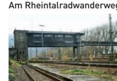
Das Reiterstellwerk von 1934 (Bauplan datiert) in Stahlbauweise überspannt das Gleisfeld des bis in die 1980er Jahre verkehrstechnisch bedeutenden Bahnbetriebswerks Bingerbrück.
