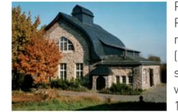
Pittoresk anmutendes Pumpwerksgebäude in rauhem Bossenquaderwerk (Inscripftafel am straßenseitigen Portal: „Wasserkwerk der Stadt Bingen 1906“). In Formen des Jugendstils gestalteter Bau mit geschwungenem kielbogenförmigem Dach und aufgesetztem Reiter; Verlust der ursprünglichen Maschinenausstattung lange vor der Renovierung. Rückwärtig Wohnhaus für den Maschinisten in stilistischer Anlehnung an das um 1984 grundlegend sanierte Pumpwerksgebäude.
